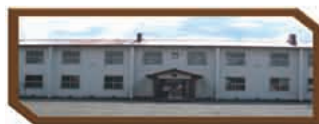
写真1 緑ヶ丘小学校
