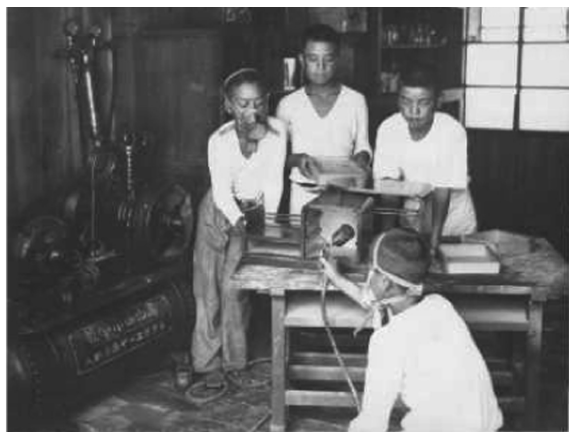
写真3 西小学校塗装室での作業（中西提供） 左手壁面に、大型のコンプレッサーが配置され防塵マスクで塗装作業をおこなっている
