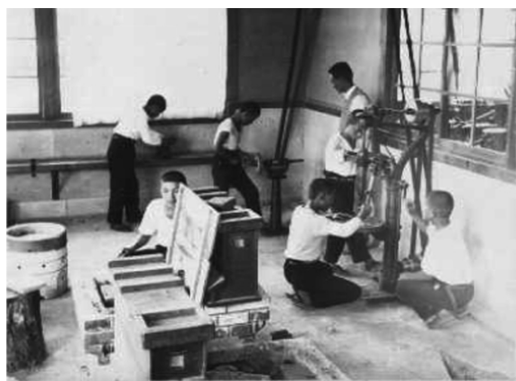
写真2 西小学校機械室の各種工作機械 (中西提供)
