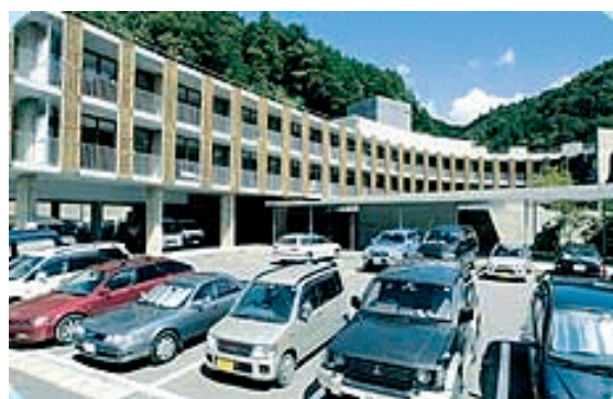
図6 揖斐郡北西部地域医療センター「山びこの郷」 資料：揖斐川町ホームページより
