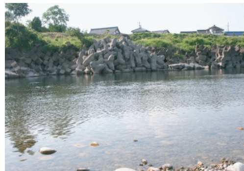
図5 堤防内側のテトラポット
