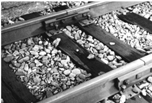
図7 東海道線（在来線）の軌道
