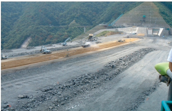
図15 工事中の徳山ダムの堰堤
