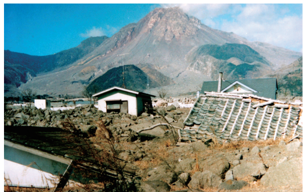
図10 雲仙普賢岳と土石流による被害
