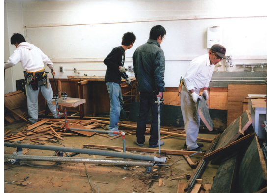
図2 実験台の解体撤去作業
