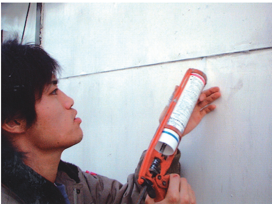
図5 外壁継ぎ目の防水処理
