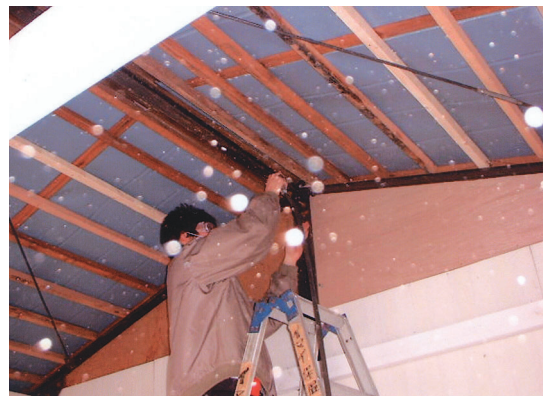
図3 小屋裏の補修作業
