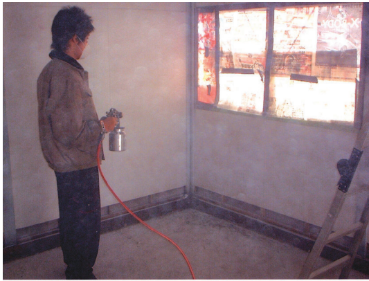
図4 内壁のスプレー塗装
