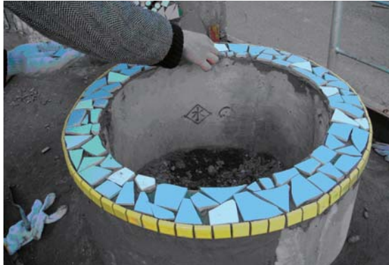
写真22 土管を装飾する破碎タイル作業
