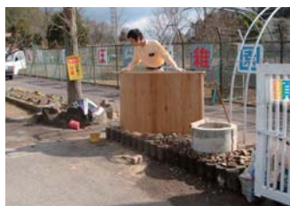
写真14-3 型枠用の曲げ合板あわせ
